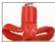
Spreizung hinter Gipskarton und Spanplatten
